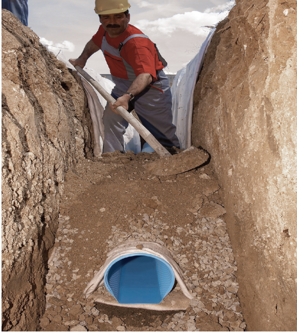
Şekil 5. İçme Suyu Sisteminde Gömlekleme
