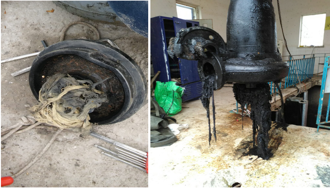
Şekil 8. TM'lerindeki Pompaların Tıkanması
