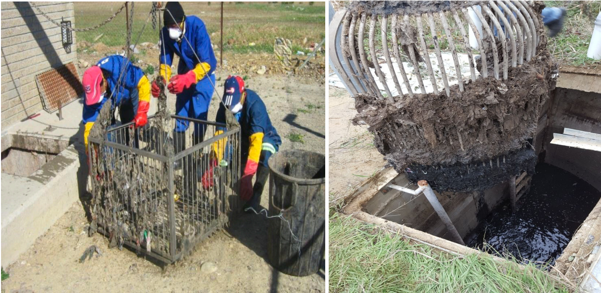
Şekil 4. TM'lerinde Tıkanan Izgaralar
