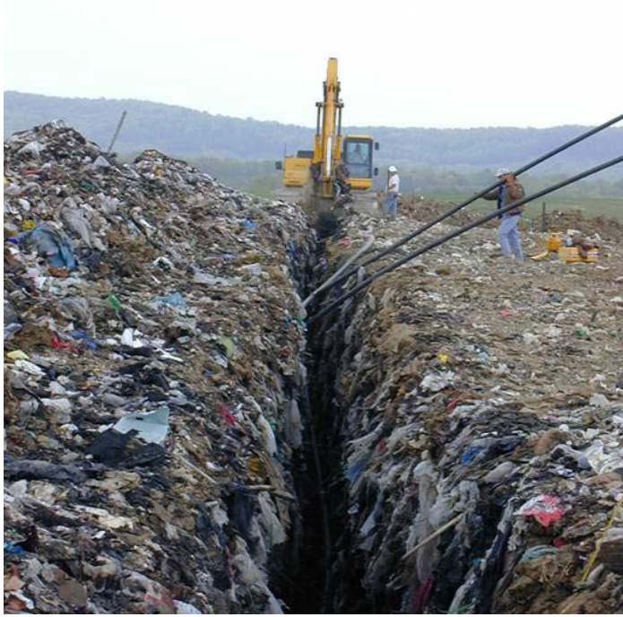
Şekil 2-3. Paletli Ekskavatörle Yatay Hendek Açılması
