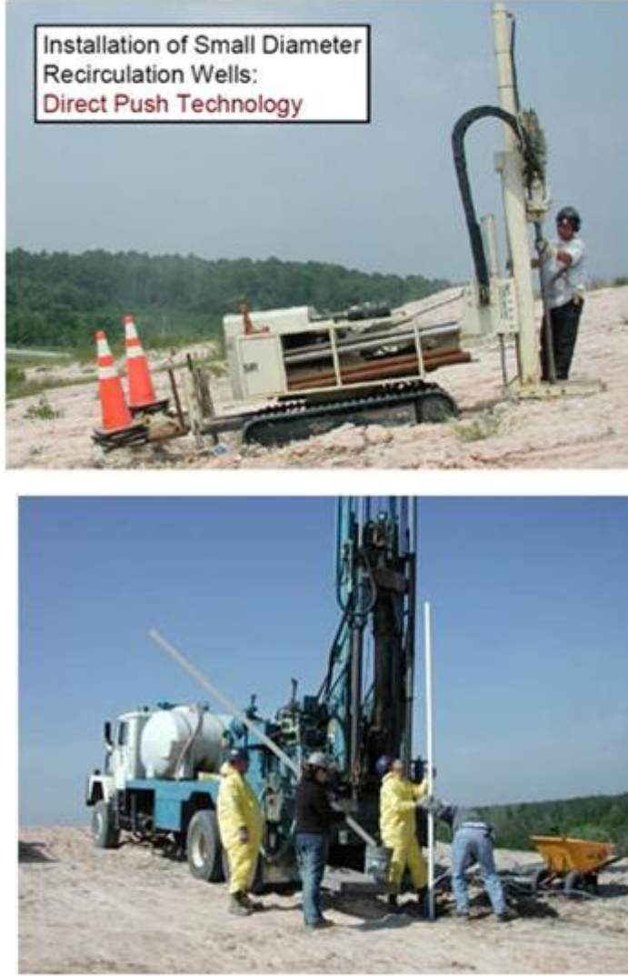
Şekil 3.2. Dikey Enjeksiyon Kuyusu Açma
