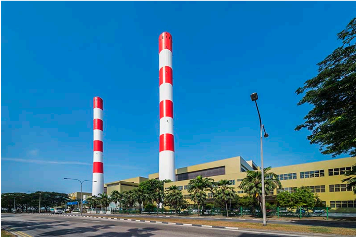
Şekil 1-2. Singapur'da Atık Yakma Tesisi
