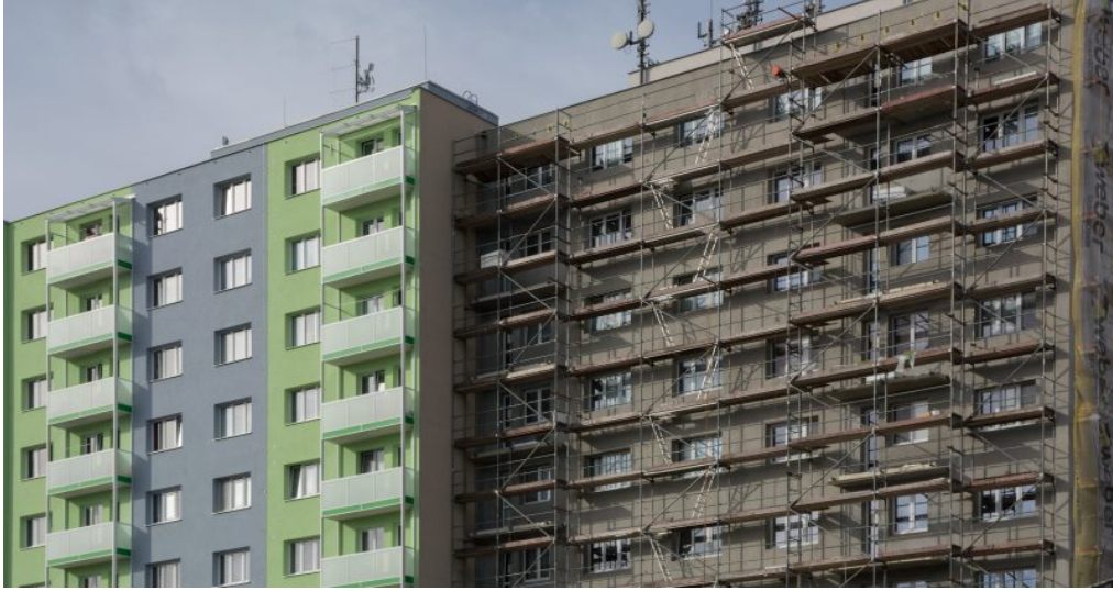
Şekil 3-7. Derin Yenilenmesi Yapılmış Bina ile Yalıtımsız (Enerji Verimsiz) Bina Görüntüsü
