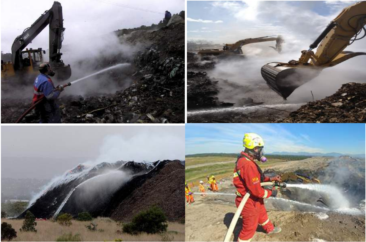
Şekil 3-3 Yeraltı Yangınlarını Söndürme
