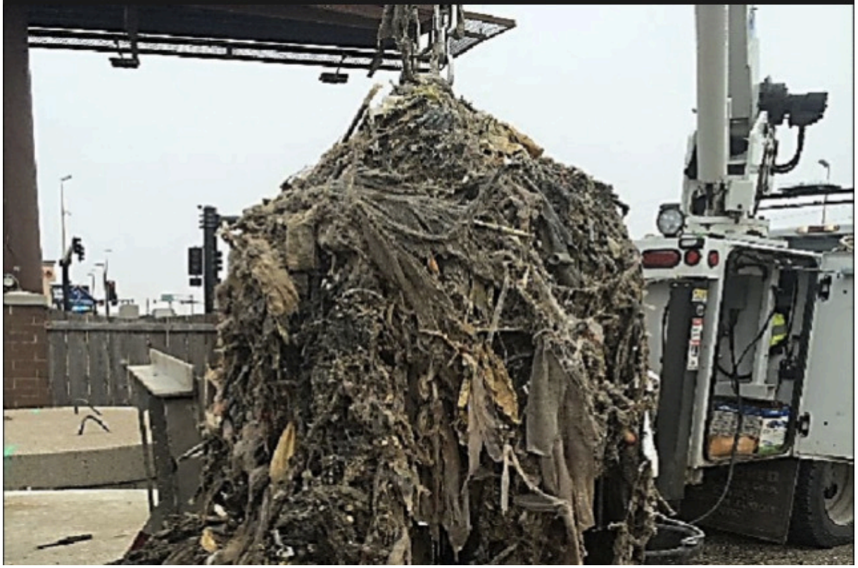
Şekil 17. Kanalizasyondan Çıkan Islak Mendiller
