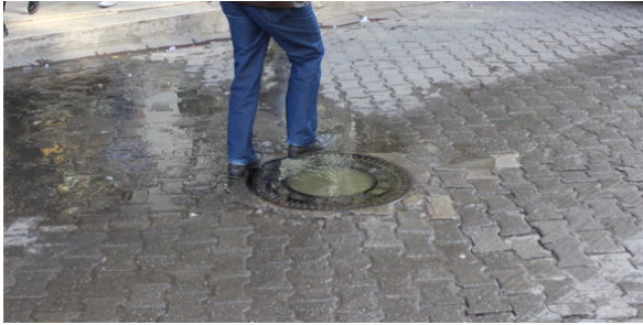
Şekil 5. Kanalizasyon Hattında Taşkın.
