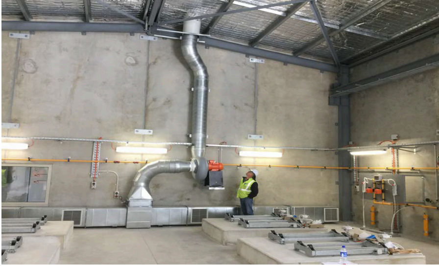
Şekil 2. Klor Gazı Depolama Odası İç Ortamında Hava Emme Sistemi
