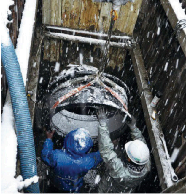
Şekil 3. Büyük Doğu Japonya Depremi Sonrasında 800 Mm Çaplı Bir Su Dağıtım Borusunun Tamiri
