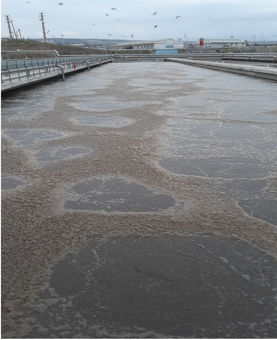
Şekil 4. Atıksu Arıtma Tesisine Sızıntı Suyu Beslenmesi Sonucu Havalandırma ve Çöktürme Ünitelerinde Oluşan Çamur Kabarması Görüntüleri
