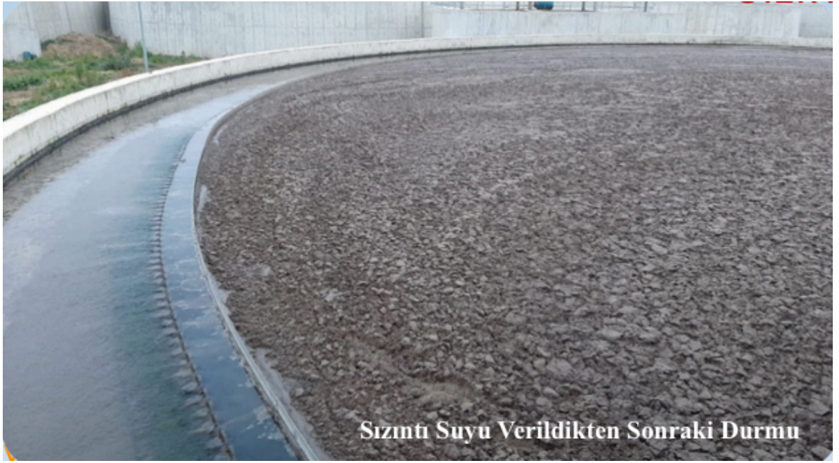
Şekil 2. Atıksu Arıtma Tesisine Sızıntı Suyu Verilmeden Önceki ve Sonrası Havuz Yüzeyi Görüntüleri
