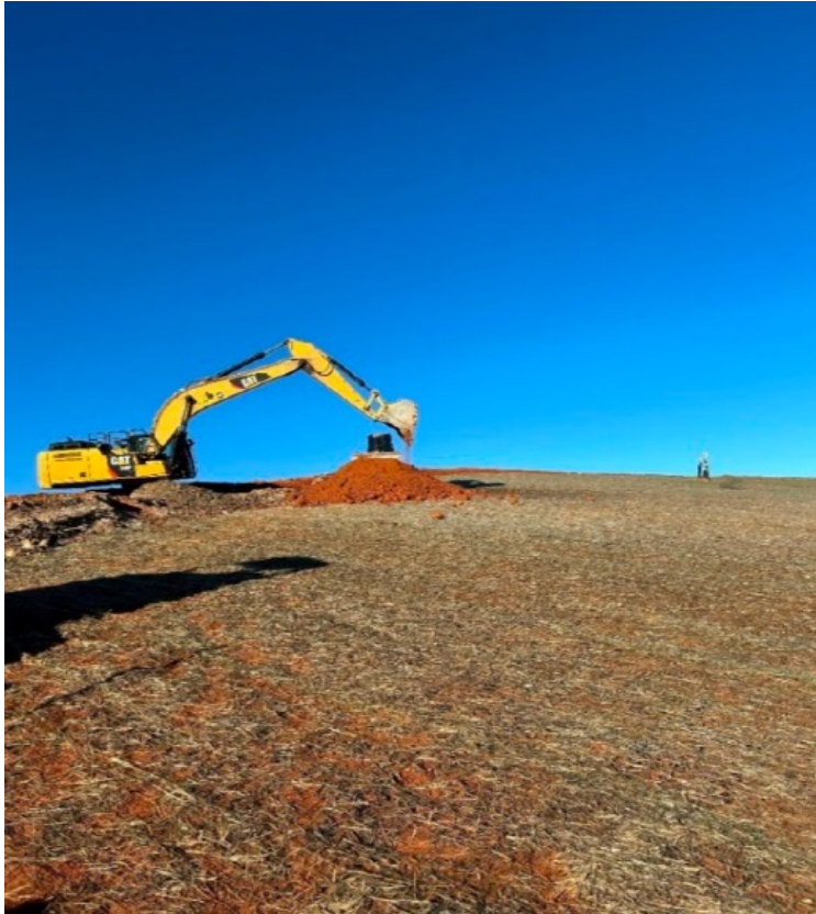
Şekil 3-3. Yeraltı Yangınında Kazı İşlemi
