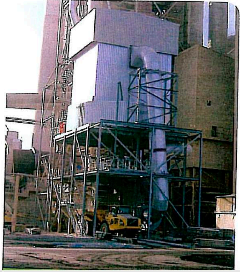
Şekil 5-4 İnce Tozlar Tutmak İçin Torbalı Filtre
