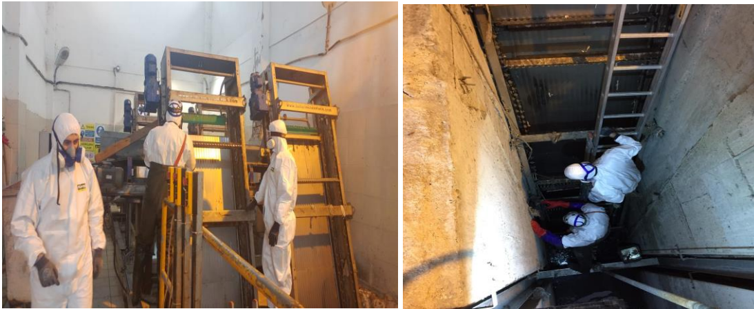
Şekil 11. Kanalizasyon Şebekesi Terfi Merkezinde Çalışanlar
