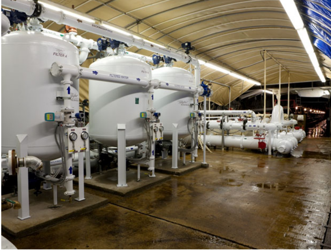
Şekil 7 Arsenik (V) Gideriminde Pıhtılaştırma ve Filtrasyon Sistemi
