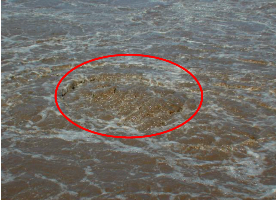
Şekil 12. Tahrip Olmuş Havalandırıcı
