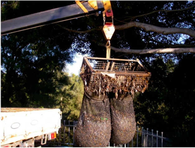
Şekil 3. Terfi Merkezlerinde Pompaların Katı Atıkları ile Tıkanması ve Kontrolü İçin File Sistemi
