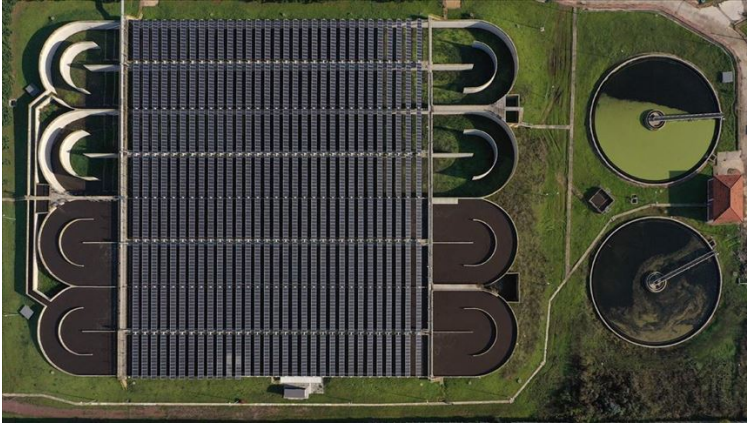
Şekil 9. Atıksu Arıtma Tesisinde GES Uygulaması
