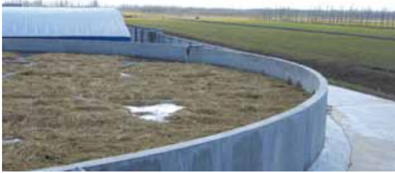
Şekil 9. Taze Doğranmış Çürüme Ürünü İçin Açık Depolama Tankı Sıvı Yüzeye Saman Yayıldı
