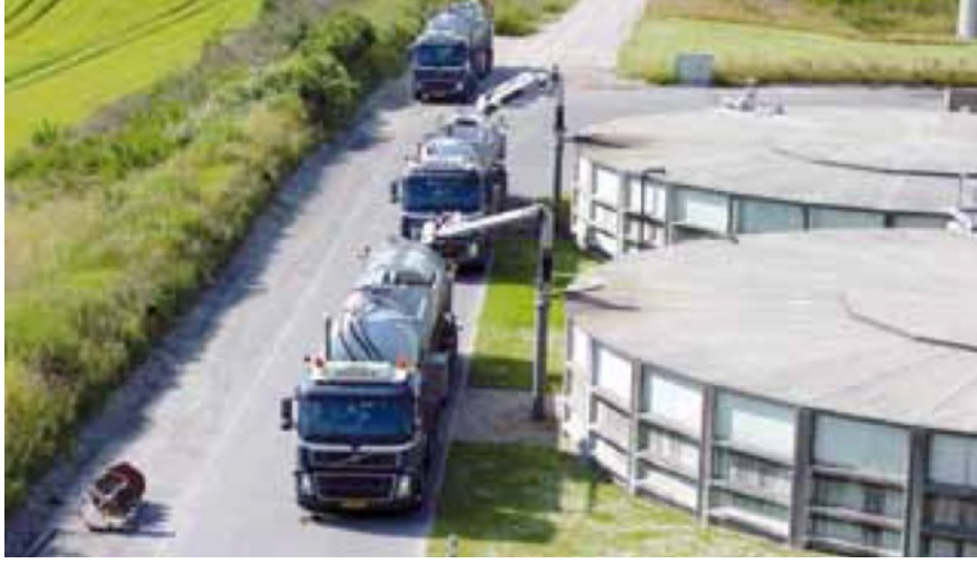
Şekil 8 Danimarka'daki Lemvig AD Fabrikasında Beton Kapaklarla Kaplı Çürüme Ürünü Depolama Tankları. Kaynak: Lemvig Biyogaz
